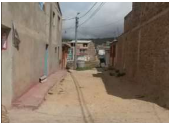
VIAS EN MAL ESTADO
